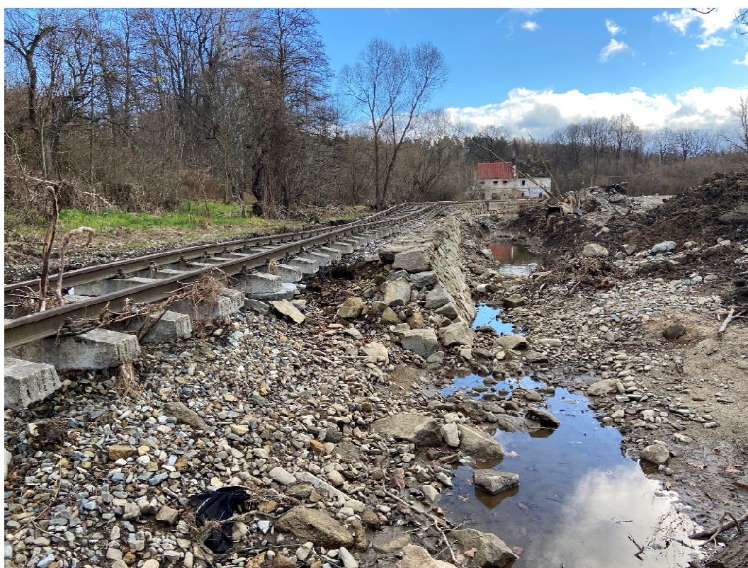
Obrázek 6 - poškozený násep, Kobylá nad Vidnávkou 09/2024
