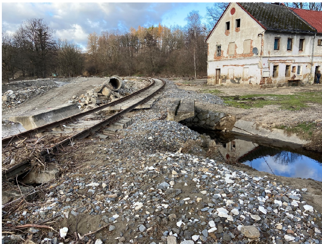
Obrázek 5 – poškozený násep a propustek na bezejmenném přítoku, Kobylá nad Vidnávkou 09/2024
